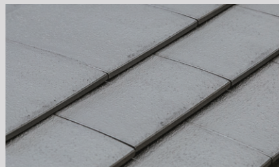
千鳥葺きした葺設状態
