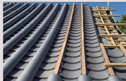
乾式加工した葺設状態
